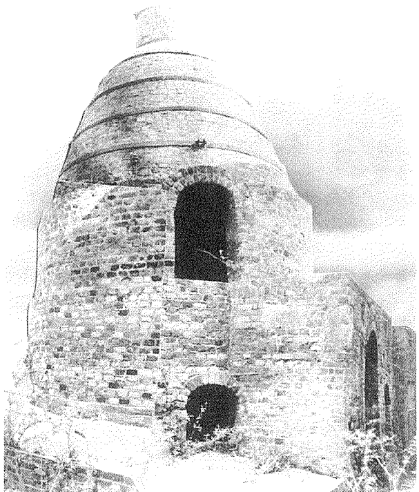
写真-3 アスプディンの建設した堅窯
