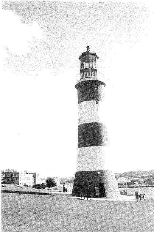
写真-1 スミートンの造ったエディストーン灯台
