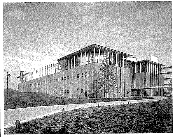
図-1 建築概要と全景写真
