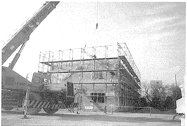
写真-6 部材吊上げ状況
