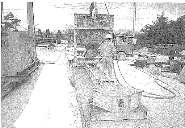
写真-3 PCaブレース製造状況
