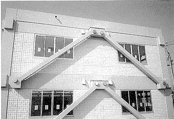
写真-2 PCaブレース設置状況
