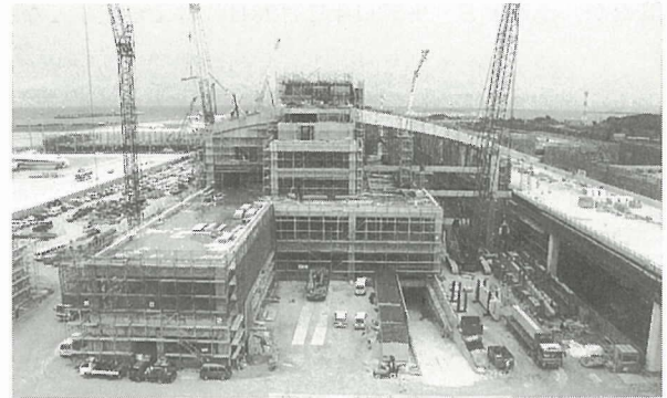
写真-2 施工状況
