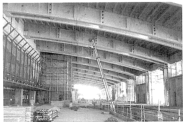
写真-7 建物内部
