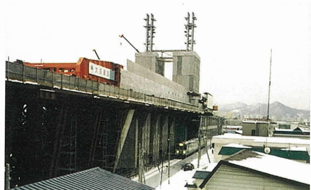
写真-2 ブロック押し出し施工状況
