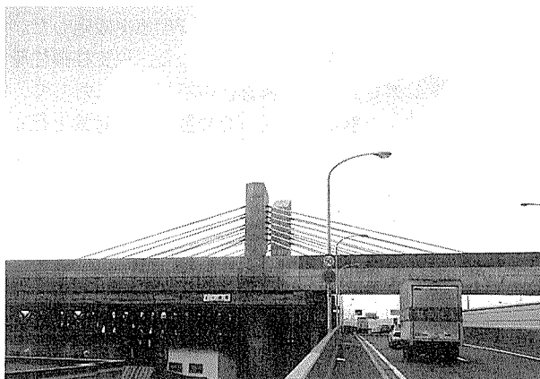
写真-14 完成時全景
