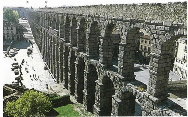
写真-2 セゴビアのローマ水道橋 スペイン
