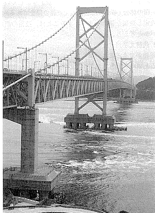
写真-8 鳴門大橋の多柱式基礎と鳴門の渦 (高楊裕幸氏撮影)
