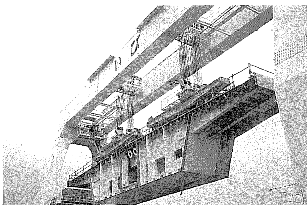
写真-7 完成した接合桁セグメント（鋼桁側より）
