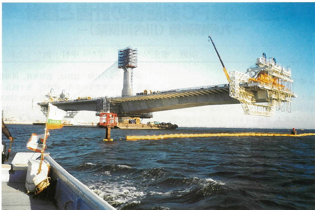
写真-12 接合桁架設終了
