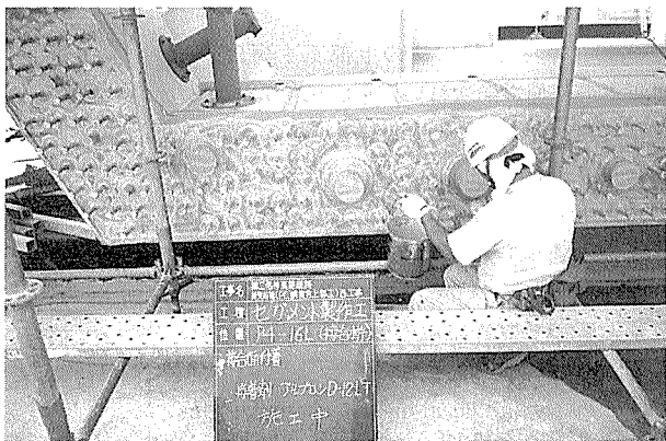
写真-2 コンクリート打設面(前面)への接着剤塗布状況
