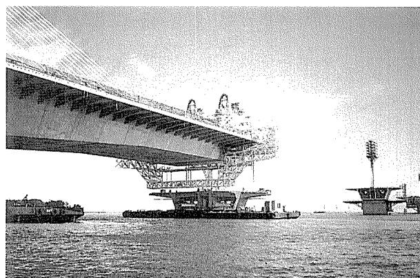
写真-10 エレクションノーズによる接合桁の吊上げ
