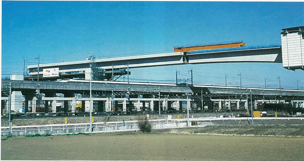
写真-7 押し出し完了時全景
