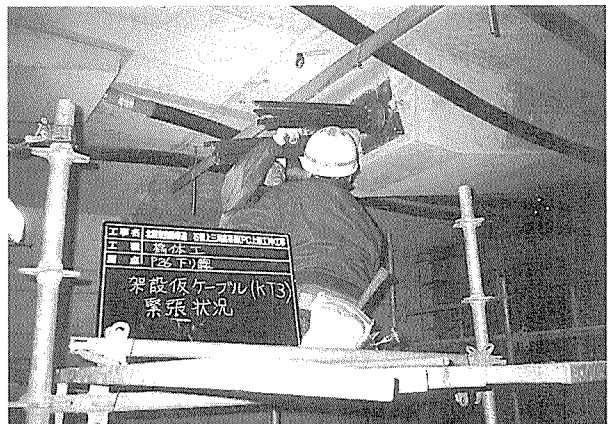
写真-1 架設PC鋼材緊張状況
