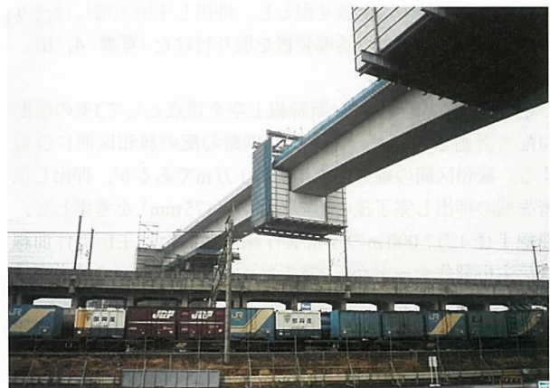
写真-8 中央閉合吊り支保工
