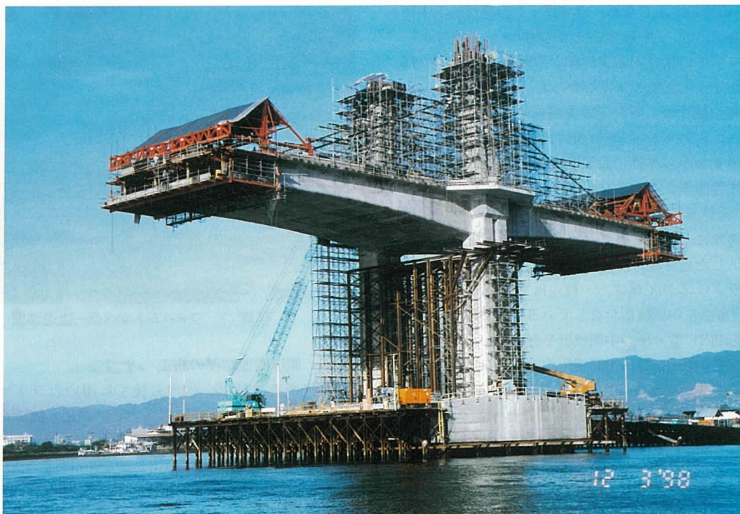
写真-3 大型フォームトラベラー
