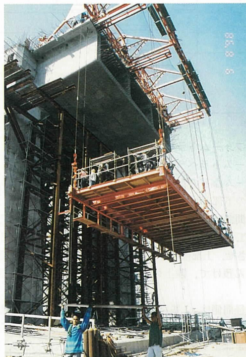
写真-5 フォームトラベラーの床材吊上げ
