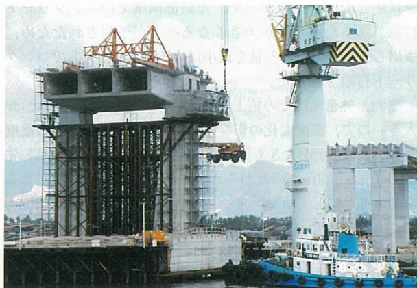
写真-4 20t クレーンの吊上げ
