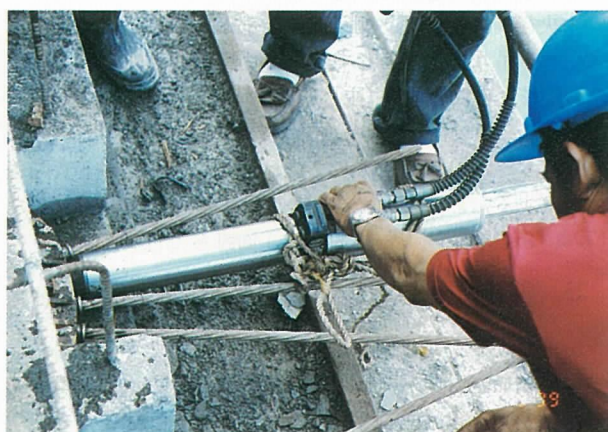
写真-6 床版横締めPC鋼材
