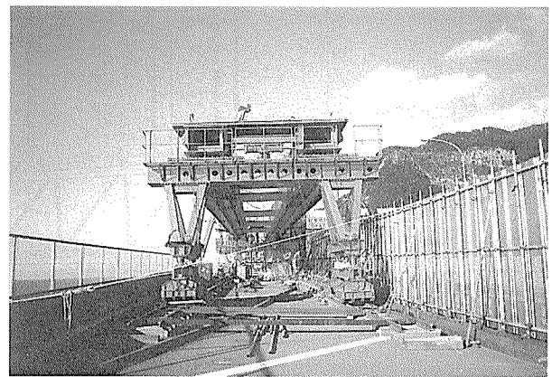
写真-8 架設桁組立て状況②
