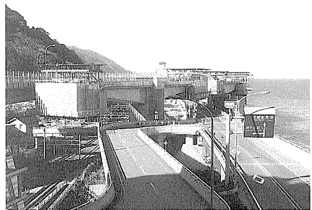
写真-2 P2・P3橋脚部張出し施工
