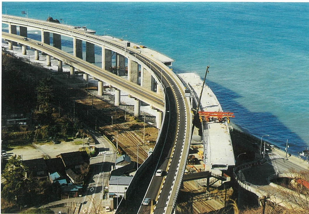
写真-4 平成10年度施工時
