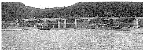
写真-3 海上部からの全景
