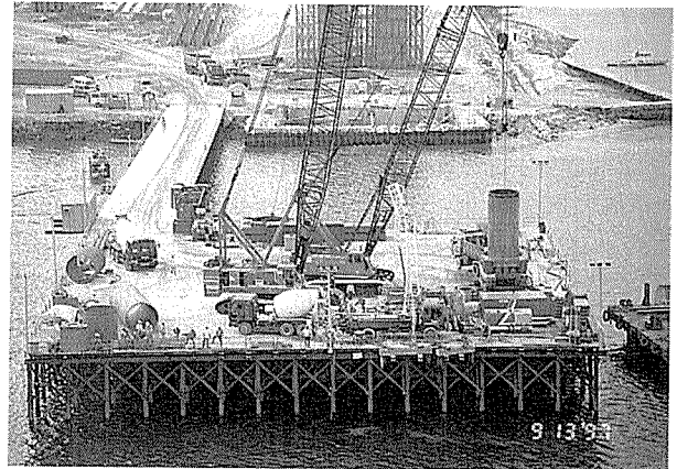
写真-6 全旋回ボーリングドライブ工法
