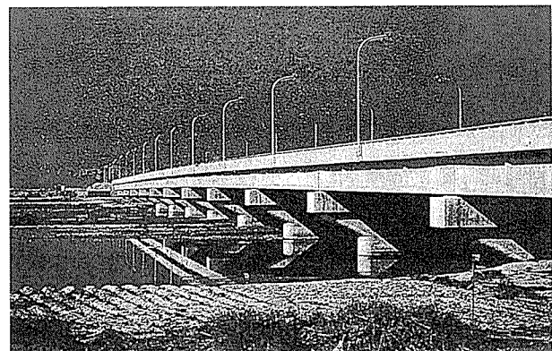
写真-3 ニザムディン橋
