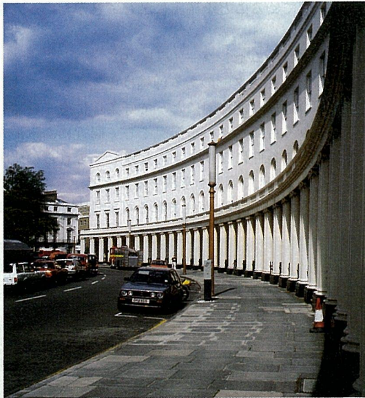
写真-5 パーククレセント
