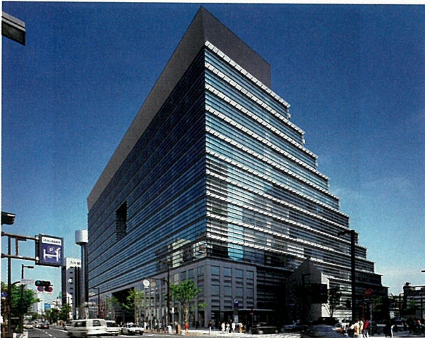
写真-15 ビジネス街区としての景観
