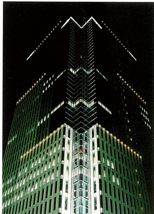
写真-9 ハーモニータワー（東京） 〈RC、SRC造高層建造物、外壁—PC板〉
