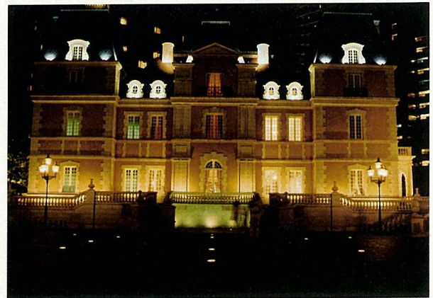
写真-6 恵比寿ガーデンプレイス(東京) 〈RC, SRC, S造建造物, 外壁一石貼り, 吹付け〉
