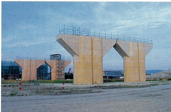
写真-1 建設現場の風景、JCT中心部（'99.7撮影） ©Studio Han Design
