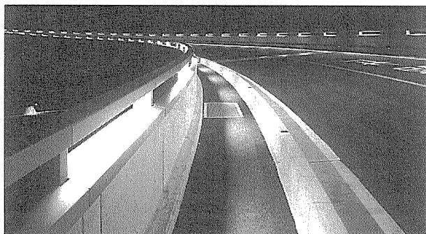
写真-11 曲線橋の視認性の向上に配慮 (写真:安川千秋氏)
