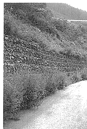
写真-14 工事用仮設道路の擁壁
