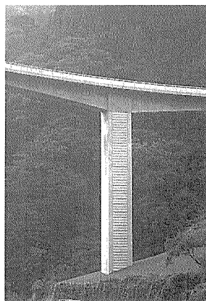
写真-13 橋脚基部埋戻し状況
