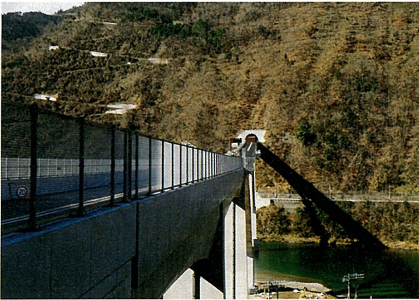
写真-5 落下物防止柵設置状況
