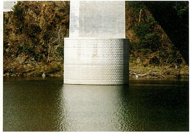
写真-7 橋脚表面処理状況①
