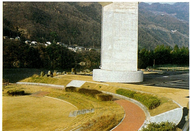
写真-8 橋脚表面処理状況②
