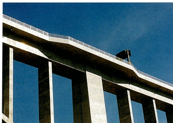
写真-4 非常駐車帯部
