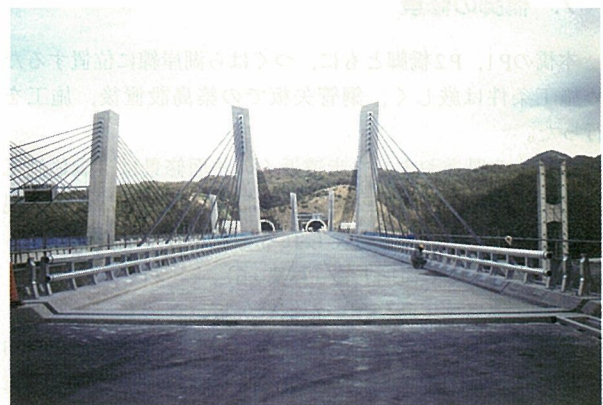
写真-4 鋼製高欄
