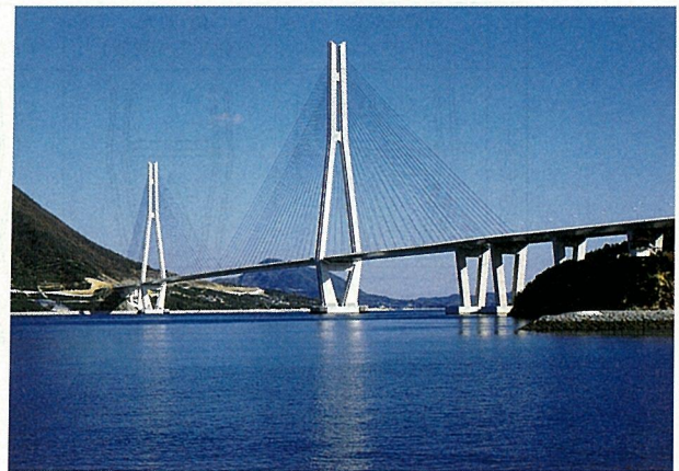
写真-2 多々羅大橋全景
