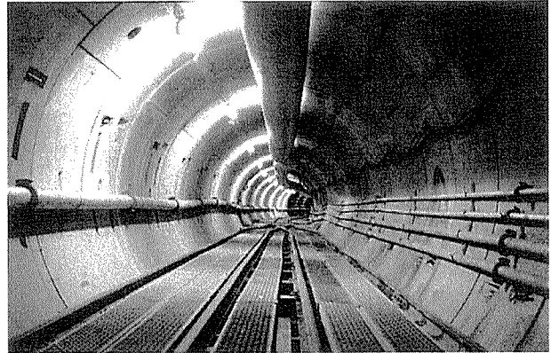
写真-13 坑内全景
