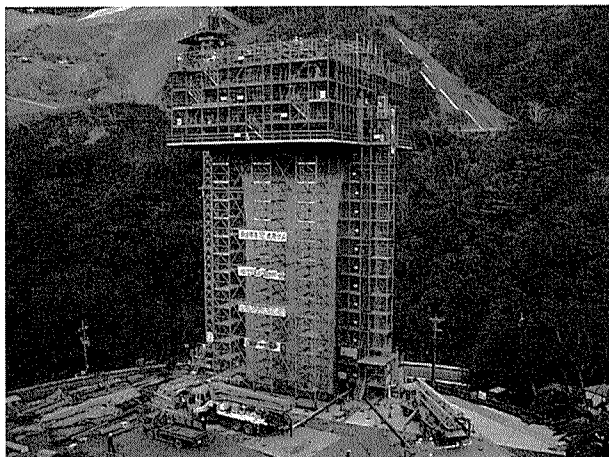
写真-2 柱頭部足場支保工
