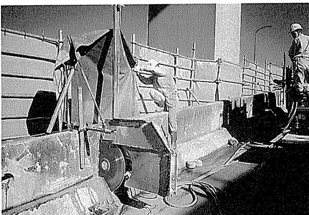
写真-4 壁高欄ウォールソー切断
