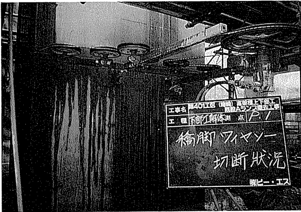
写真-7 橋脚ワイヤーソー切断
