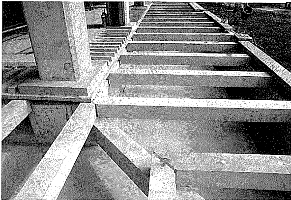
写真-12 柱脚部台座
