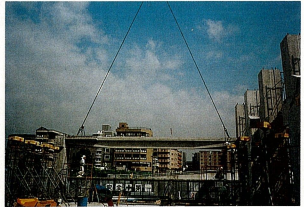
写真-9 ST梁架設2(施工)
