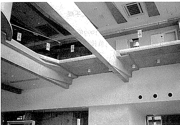
写真-5 ST梁とハーフPC床版との納まり(内観)
