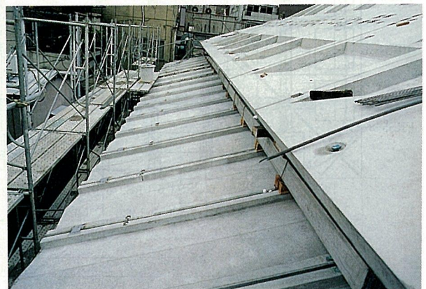
写真-11 屋根版取合い
