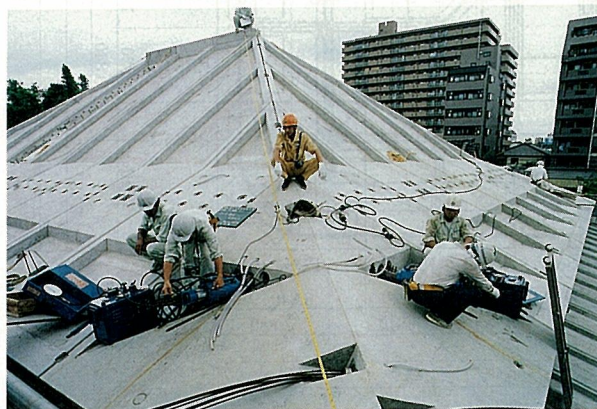
写真-10 屋根緊張状況
