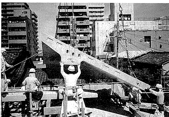
写真-15 桁材コネクター
