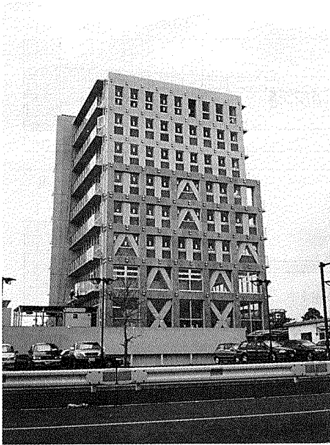
写真-1 全景(東面)
