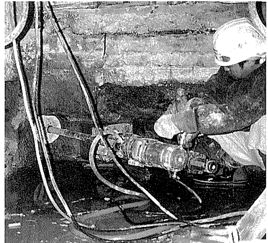
写真-1 基礎横孔削孔
