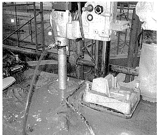
写真-2 煉瓦壁縦孔削孔
