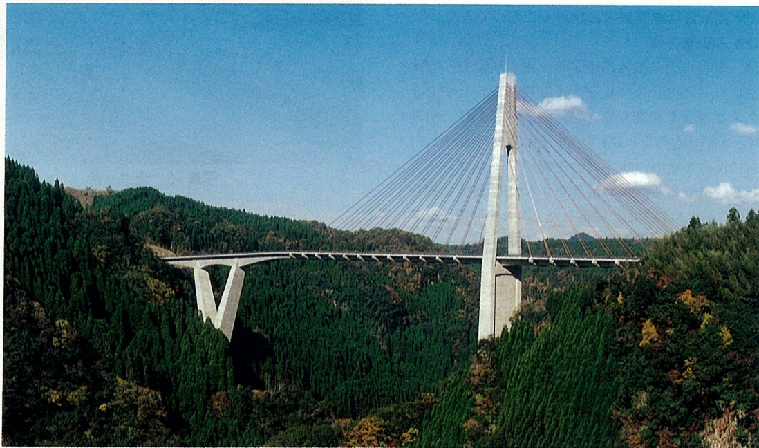
写真-1 完成写真
