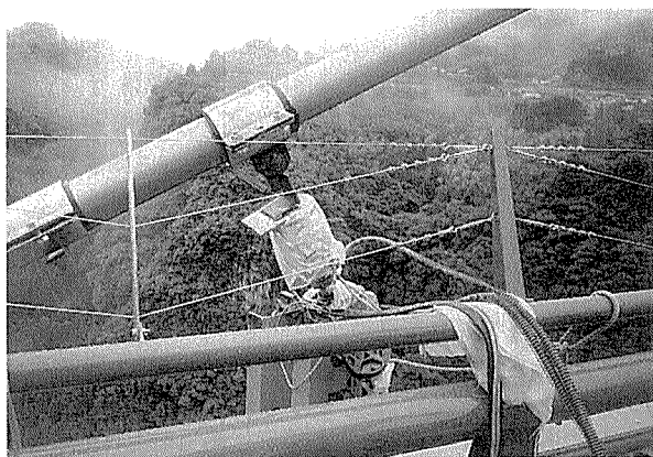
写真-10 ケーブル振動試験
