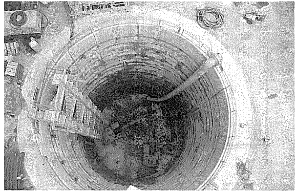
写真-2 大口径深礎の施工
