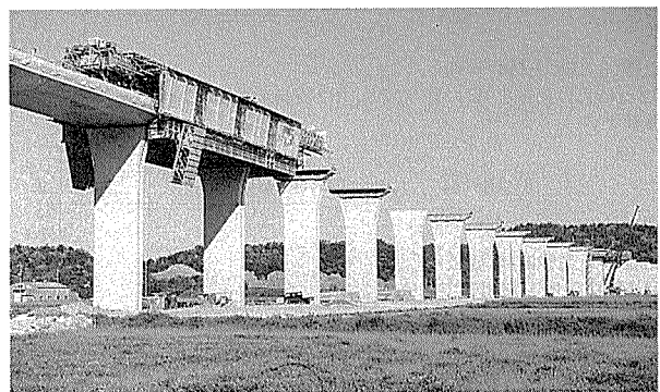
写真-3 施工中の移動支保工（後方より）
