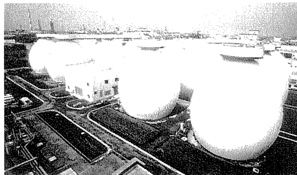
写真-9 横浜市北部第二下水処理場(神奈川県)
