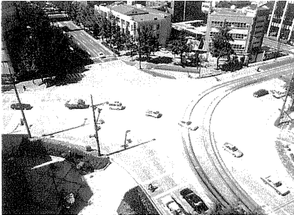
写真-16 辛島町プレキャストPC版舗装(熊本県)
