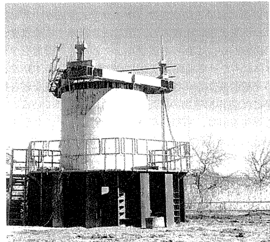
写真-18 新大利根川大橋PCウェル橋脚(茨城県)
