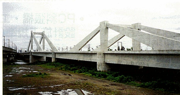
写真-2 東北本線名取川橋梁
