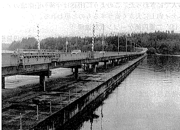
写真-4 フッド・カナル浮体橋の外観
