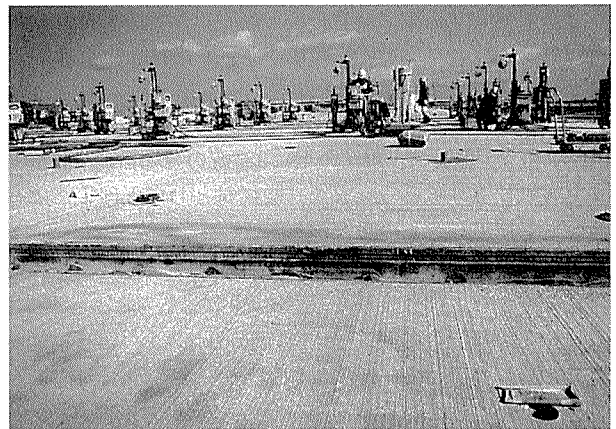
写真-2 リフトアップ状況
