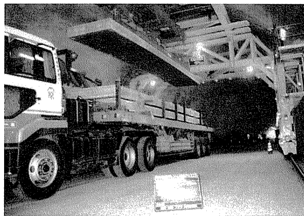
写真-10 天井版の架設
