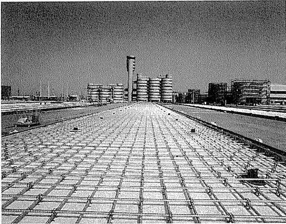
写真-1 PC舗装 シース組立て
