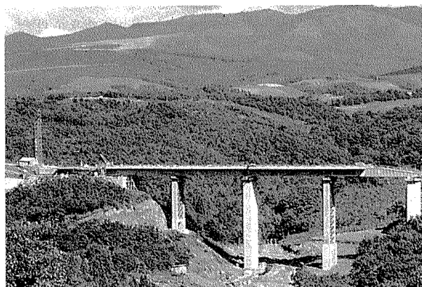
写真-9 幌萌大橋
