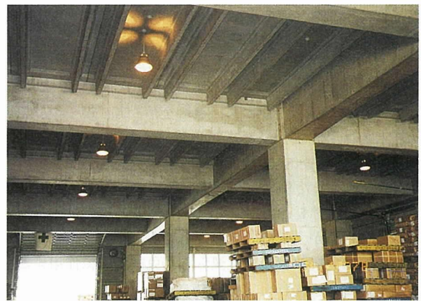
写真-2 六甲アイランド4号倉庫内部
