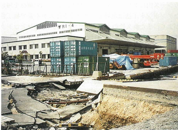
写真-1 兵庫県南部地震/六甲アイランド4号倉庫の周辺
