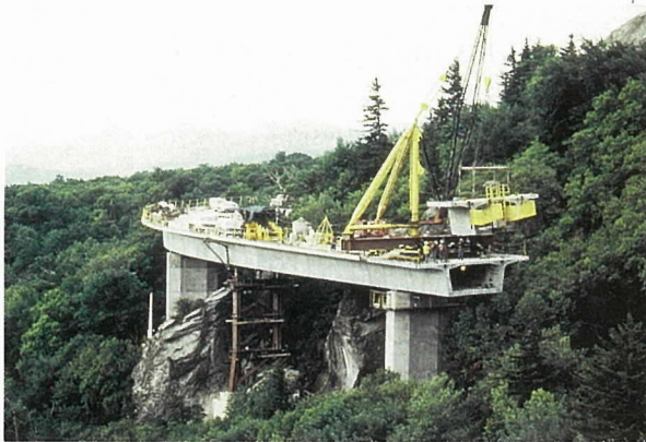
写真-1 リン・コーブ高架橋 (写真提供: Figg Bridge Engineers, Inc.)
