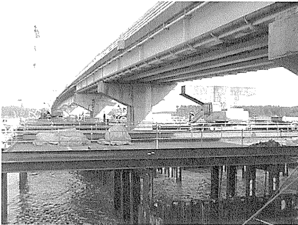
写真-1 男鹿大橋
