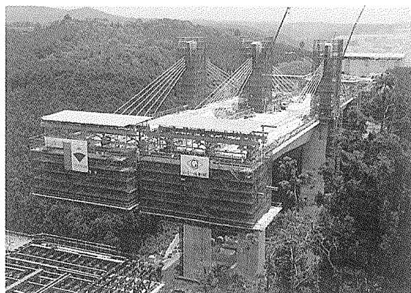
写真-5 張出し架設
