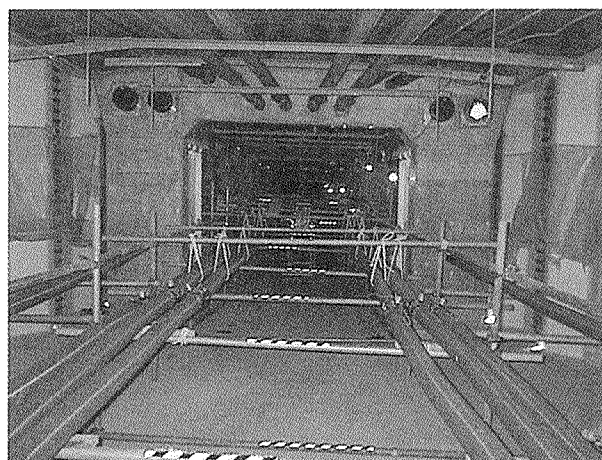
写真-6 外ケーブル配置状況
