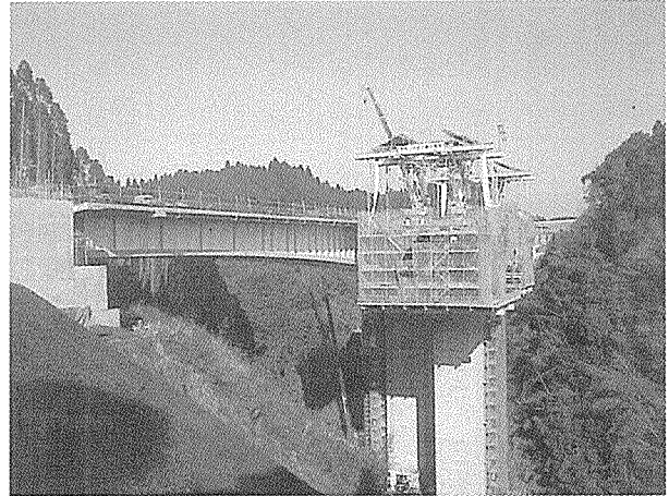
写真-7 施工進捗状況
