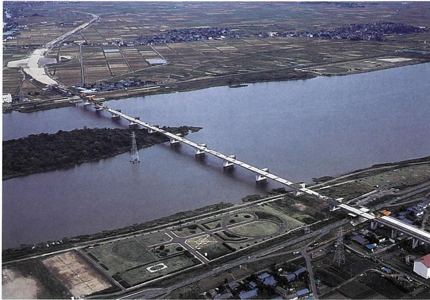
写真-2 下り線のセグメント架設完了状況 (2000年9月撮影)
