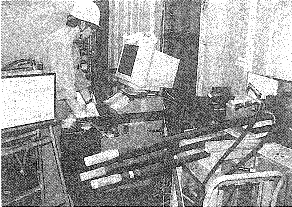
写真-3 緊張確認試験状況
