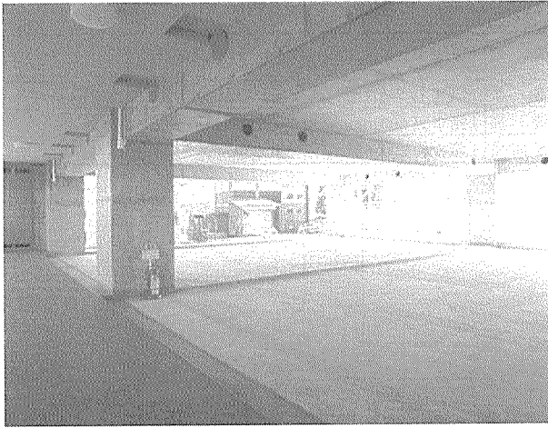
写真-3 KSI 実験棟の純ラーメン架構
