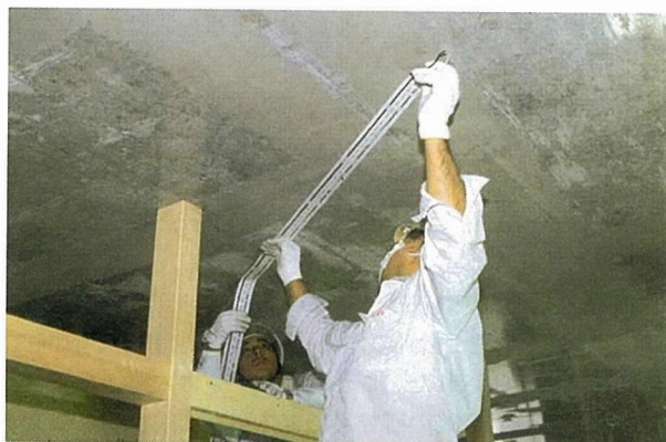
写真-1 テープケーブルの天井貼付け
