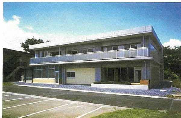
写真-2 KSI住棟外観
