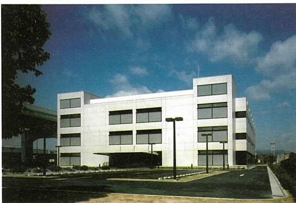
写真-1 建物外観
