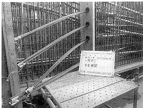
写真-4 1階梁側面PC鋼材(2次ケーブル)設置状況
