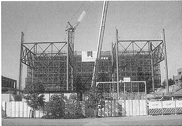
写真-4 架設中外観
