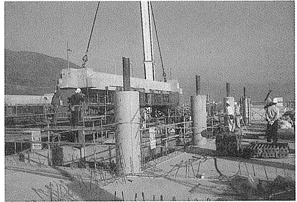
写真-5 PCa PC梁架設状況
