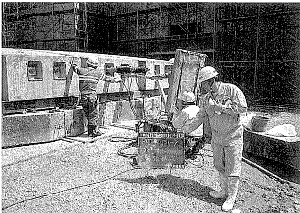
写真-7 外ケーブル緊張状況
