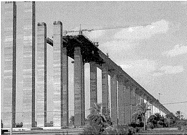
写真-2 取付け橋梁上部工の架設
