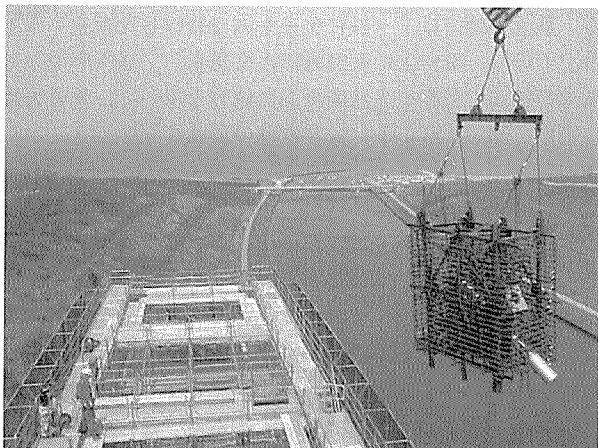
写真-4 鉄骨地組搬入（内灘大橋）
