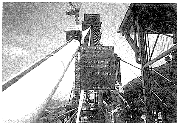
写真-11 振動法による斜材張力計測
