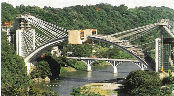
写真-1 ピロン工法（新小倉橋）
