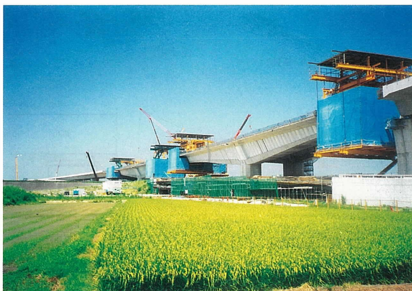
写真-3 施工中の波形鋼板ウェブ橋（2001年8月上旬）
