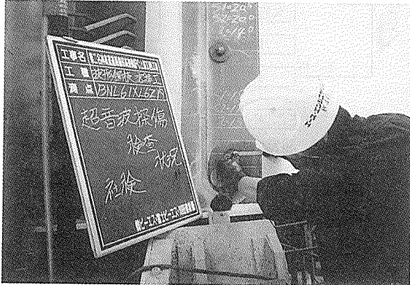
写真-1 超音波探傷試験状況
