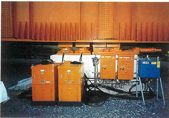
写真-2 押し装置
