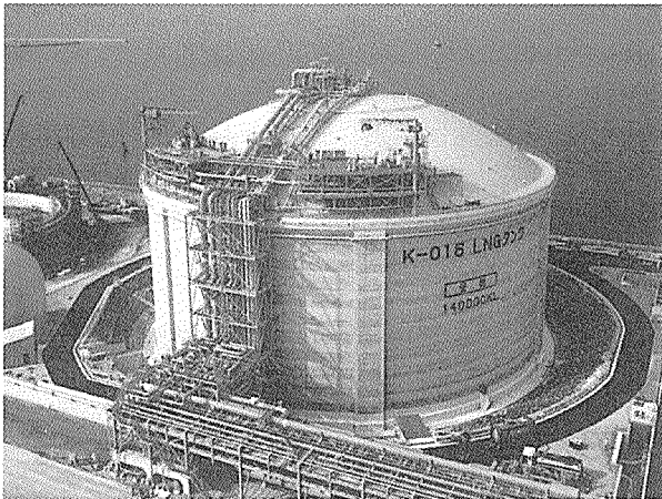
写真-4 LNGタンク (液化ガスタンク)
