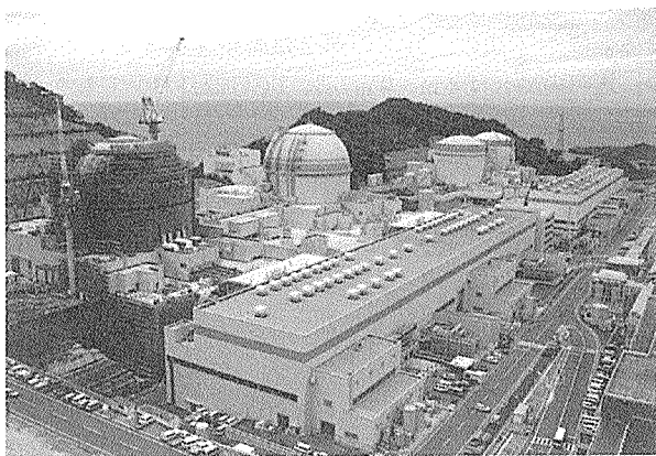
写真-5 原子炉格納容器
