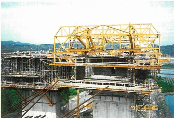
写真-2 アプローチ橋の施工
