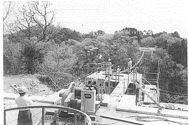
写真-1 1次ケーブル架設状況
