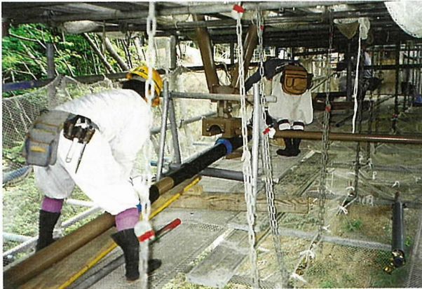
写真-5 外ケーブル架設状況 (ケーブル架設状況)
