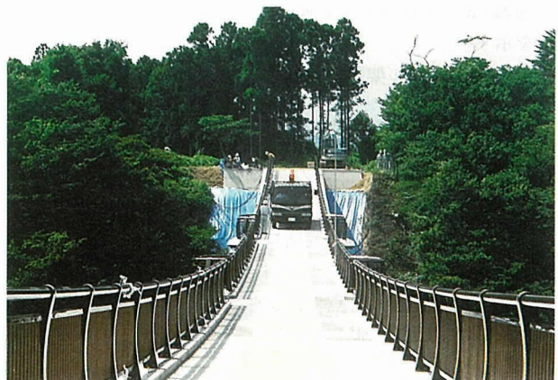
写真-7 静的載荷実験状況
