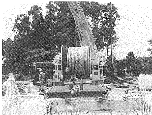
写真-4 外ケーブル架設状況 (架設機器設置状況)
