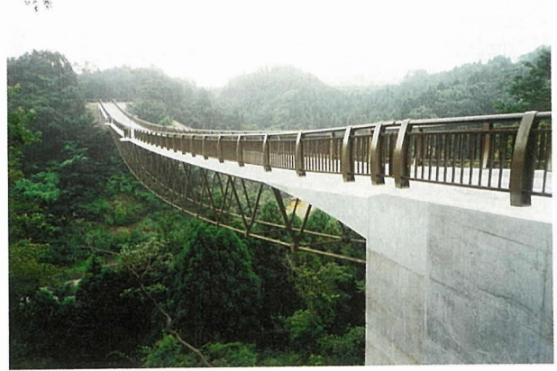
写真-6 完成写真
