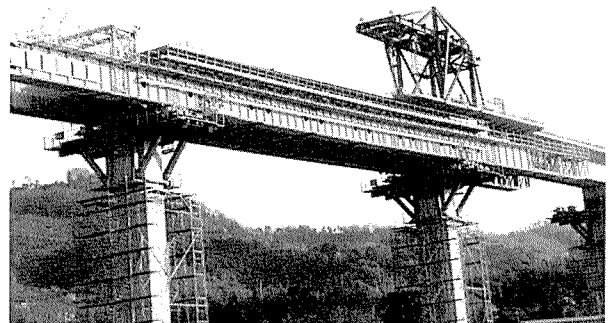
写真-2 重信川高架橋架設設備全景
